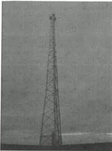
Widok obiektu wraz z zainstalowanym zespołem antenowym
