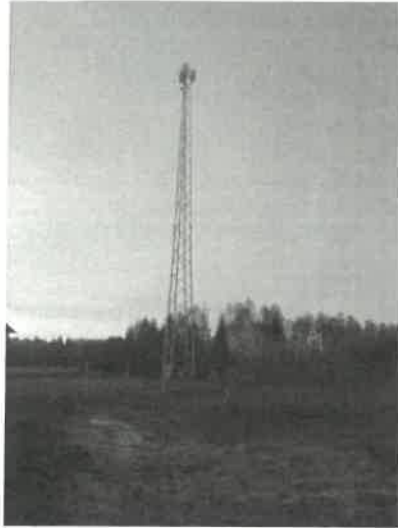
Widok obiektu wraz z zainstalowanym zespołem antenowym
