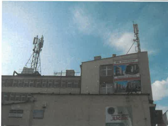
Zał. nr 1: Widok ogólny instalacji radiokomunikacyjnej.
