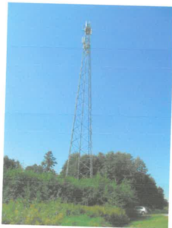
Zał. nr 1: Widok ogólny instalacji radiokomunikacyjnej.
