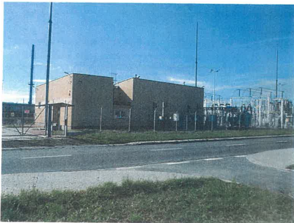
Zdjęcie 1 Badany obiekt
